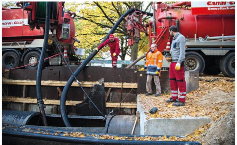
In den Baugruben wurde zunächst eine Reinigungsrevision geschaffen. Die Rohrsohle blieb erhalten, nur der Scheitel wurde geöffnet. | Fotos: Aron Winkeltau, CCC
