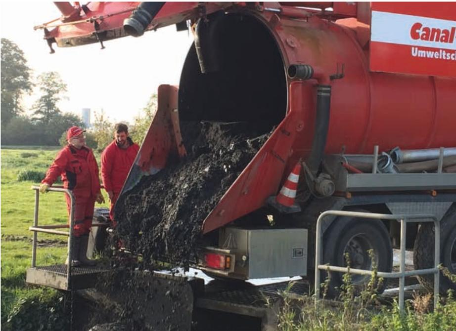
Nach Fertigstellung der Reinigung zeigte die Waage ein Gesamtergebnis von insgesamt 240 t aus der Druckrohrleitung gereinigte Kanalsande. | Foto: Aron Winkeltau, CCC
