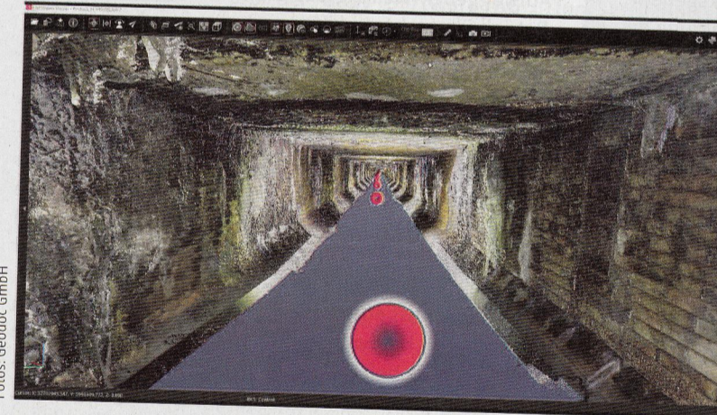
Kanalfahrt mit besonderem Clou: Optische Inspektion und Vermessung kommen aus einem System.
