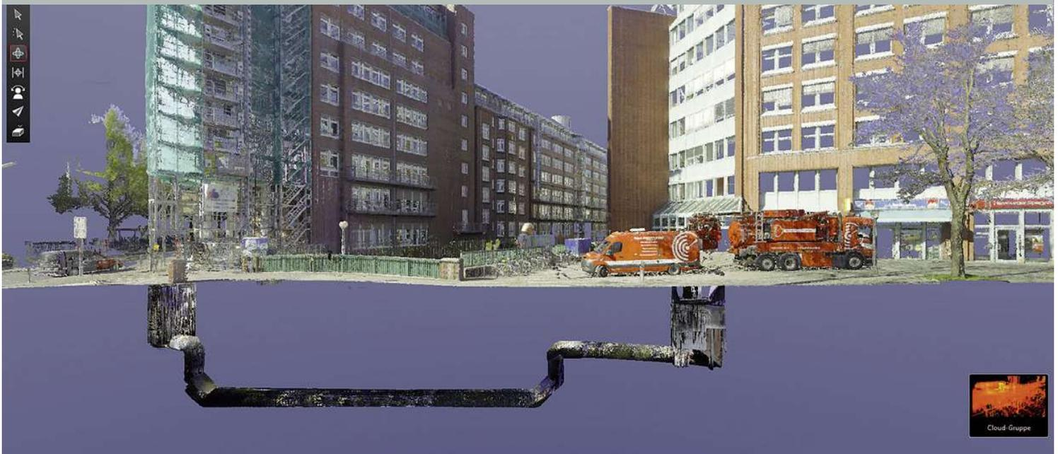
Abbildung 1: 3D-Ansicht Düker Baumwall, Hamburg | Fotos: Geodoc GmbH
