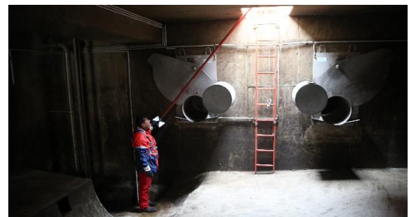
Georeferenzierung des Bauwerkes mit Kanalstab
